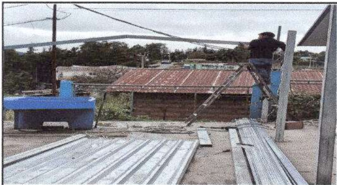
Foto 3: Sustrucción de pila de cemento de dos lavaderos
