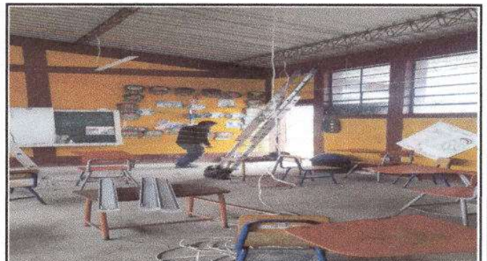
Foto 4: Sustrucción de lámparas tipo Led
