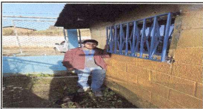
Foto 5: Sustrucción de ventana de madera por ventana de metal
