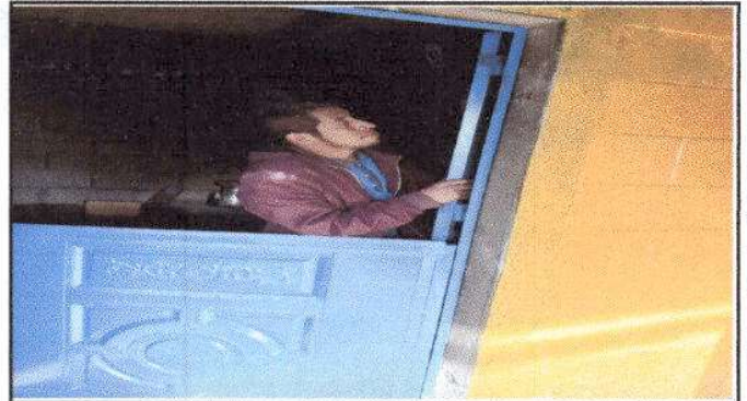
Foto 2: Sustrucción de puerta de madera por puerta de metal
